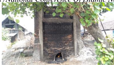
Gambar 20. Proses pembakaran kenteng
